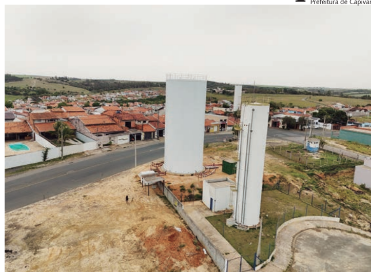
Reservatório já está em funcionamento e atendendo os bairros
