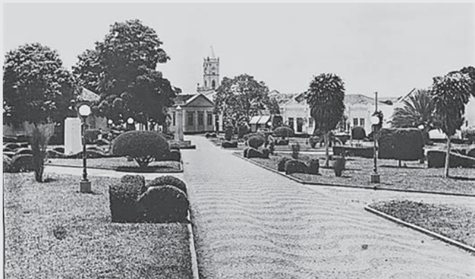
Foto de 1960 – O ipê que a “Gardênia” fala, é o que está em frente ao antigo Mercado Municipal de Capivari. Reparem que é o mais alto, estando no fundo, entre a herma de Amadeu Amaral e obelisco do Centenário da cidade
