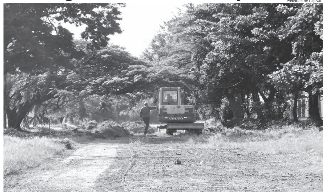
Etapas seguintes contemplarão revitalização da antiga estação da Fepasa
