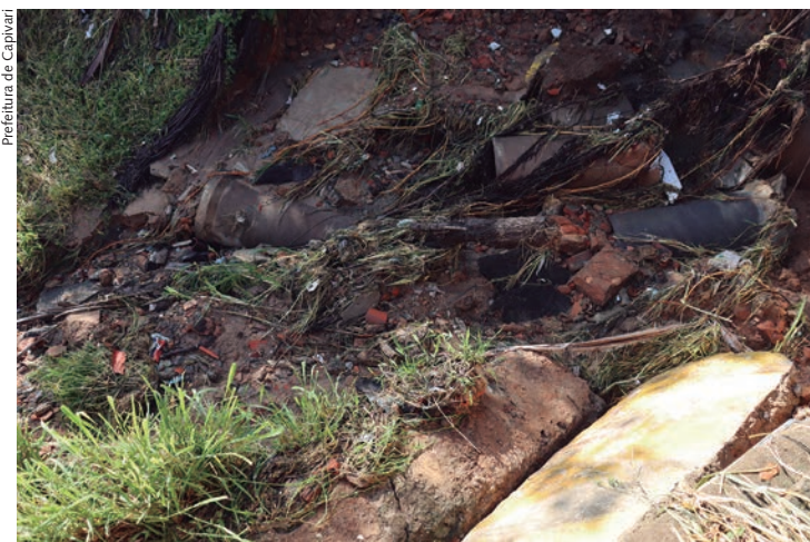
Cabeceira de uma das pontes da Chiquinho Quadros destruída
