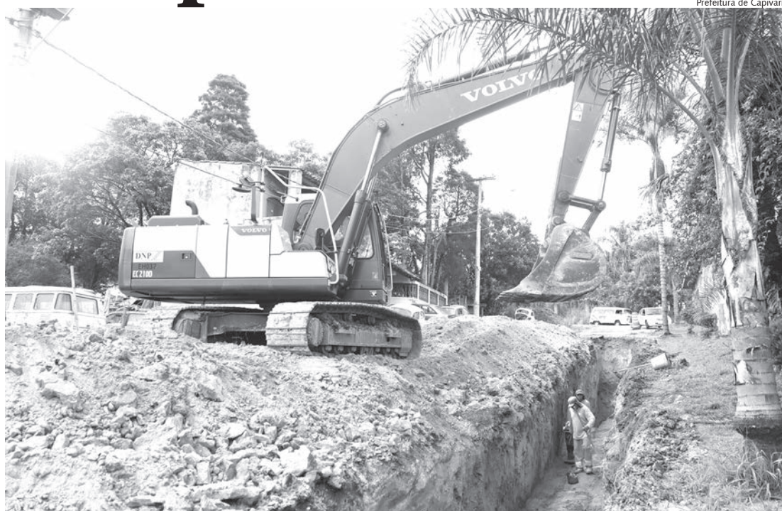
Obras no bairro Bosque dos Pinheiros tiveram início na sexta-feira (13)
