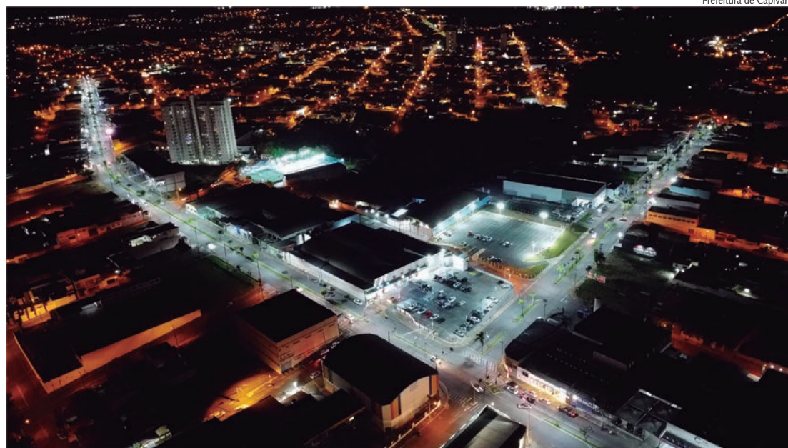
Nova iluminação das avenidas Pio XII e Piratinga se destacam
